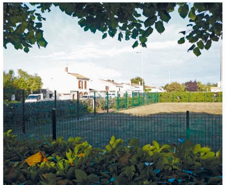
Travaux école clôture intérieure
