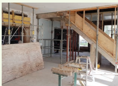
Escalier accès extérieur aux archives
