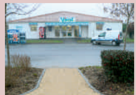
Notre supérette accessible à tous grâce à la réalisation d'une allée pour les personnes à mobilité réduite (PMR)
