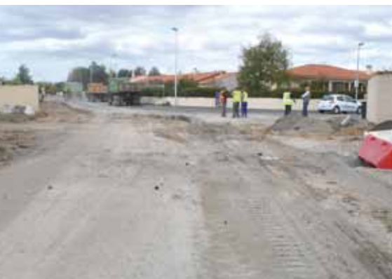
Début des travaux rue des Avocettes
